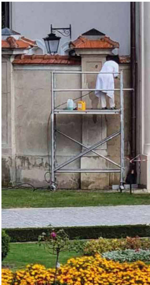
Czyszczenie muru kurtynowego
