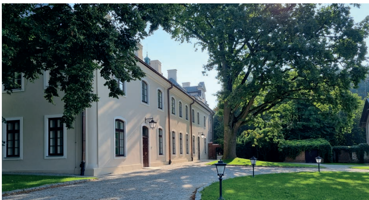
Oficyna południowa, przed i po remoncie The southern outbuilding, before and after renovation
