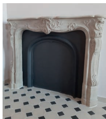
Hol na parterze, widok od strony wejścia, w trakcie i po remoncie; kominek z piaskowca, przed i po konserwacji, z usuniętą warstwą farby olejnej Hall on the ground floor, view from the entrance, during and after renovation; sandstone fireplace, before and after conservation, with a layer of oil paint removed
