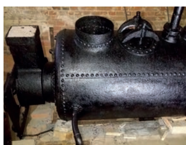
„Lapidarium”, kocioł zasilający system grzewczy kaplicy pałacowej, odkopany w trakcie prac remontowych, przed i po konserwacji „Lapidarium”, a boiler supplying the heating system of the palace chapel, unearthed during renovation works, before and after conservation
