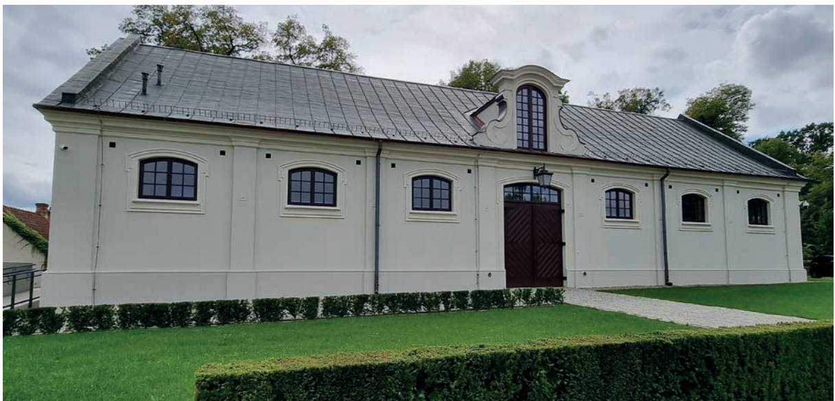
Elewacje wschodnia i północna, przed i po remoncie Eastern and northern elevations, before and after renovation
