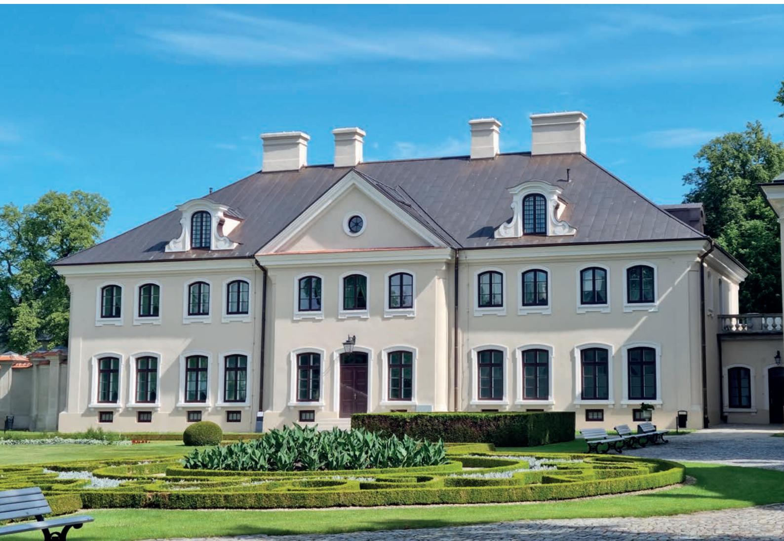
Elewacja frontowa przed, w trakcie i po remoncie Front elevation before, during and after renovation
